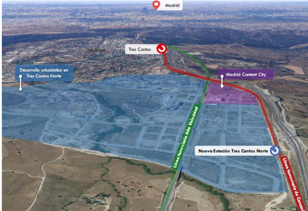
Imagen 2. Vista aérea del entorno de la nueva estación de Tres Cantos Norte en dirección sur.
